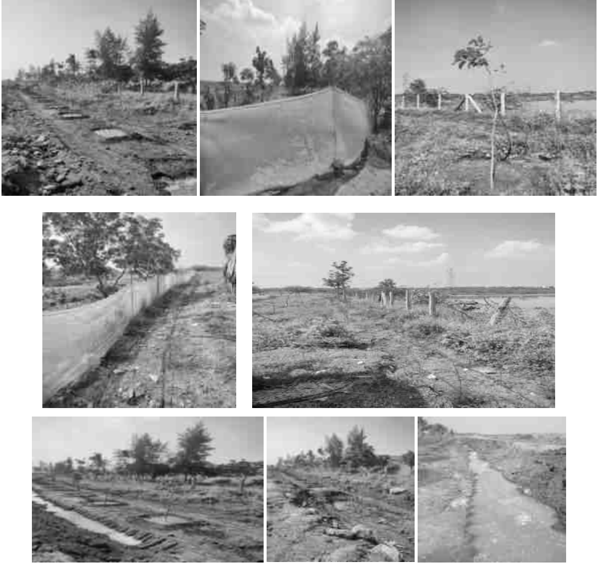
படம் 2.1-A: வேலி அமைத்தல், மாலை வடிகால் மற்றும் பசுமை அரண் புகைப்படங்கள்
